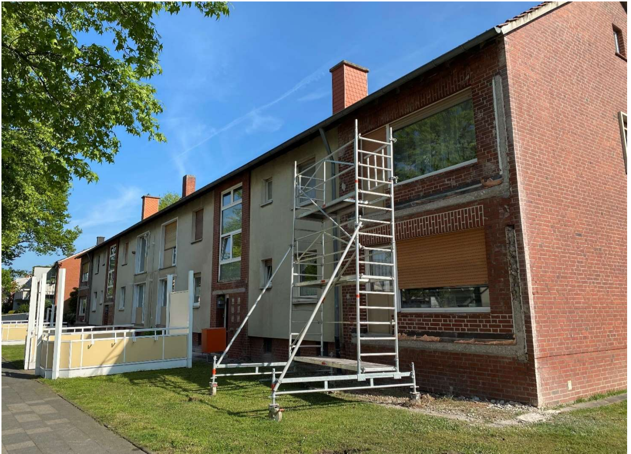
Berliner Str. 18-20: vor und nach der Sanierung
