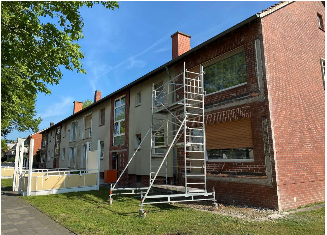
Berliner Str. 18-20: vor und nach der Sanierung
